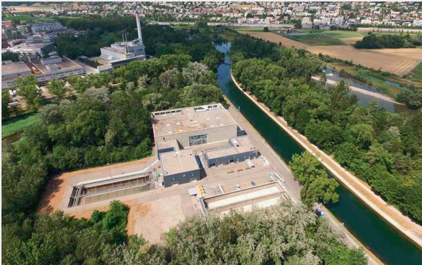
Fig. 3 Da am Standort der Limeco in Dietikon die idealen technischen und wirtschaftlichen Voraussetzungen gegeben sind, haben sich die acht Trägergemeinden der Limeco zusammen mit acht kooperierenden Stadtwerken (Box) entschlossen, eine Power-to-Gas-Anlage mit 2 Megawatt elektrischer Anschlussleistung zu bauen.
